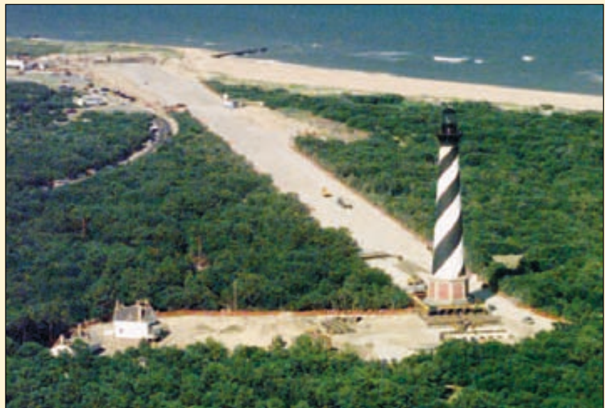
▲ Figura 20.C Cuando el faro del cabo Hatteras de Carolina del Norte fue amenazado por la erosión de la línea de costa en 1999, fue trasladado a 488 metros de la línea de costa. (Foto de Drew Wilson © 1999, Virginian-Pilot .)
