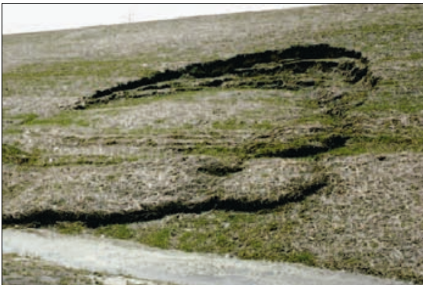
◀ Figura 15.8 Este pequeño flujo de tierra en forma de lengua se produjo en una pendiente recién formada a lo largo de una carretera recién construida. Se formó en material rico en arcilla después de un período de densas lluvias. Obsérvese el pequeño desplome en la cabecera del flujo de tierra. (Foto de E. J. Tarbuck.)
