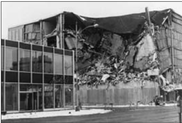
▲ Figura 11.16 Daños causados al edificio de cinco plantas J. C. Penney Co., Anchorage, Alaska. El edificio adyacente sufrió muy pocos daños estructurales. (Foto cortesía de NOAA/Seattle.)
